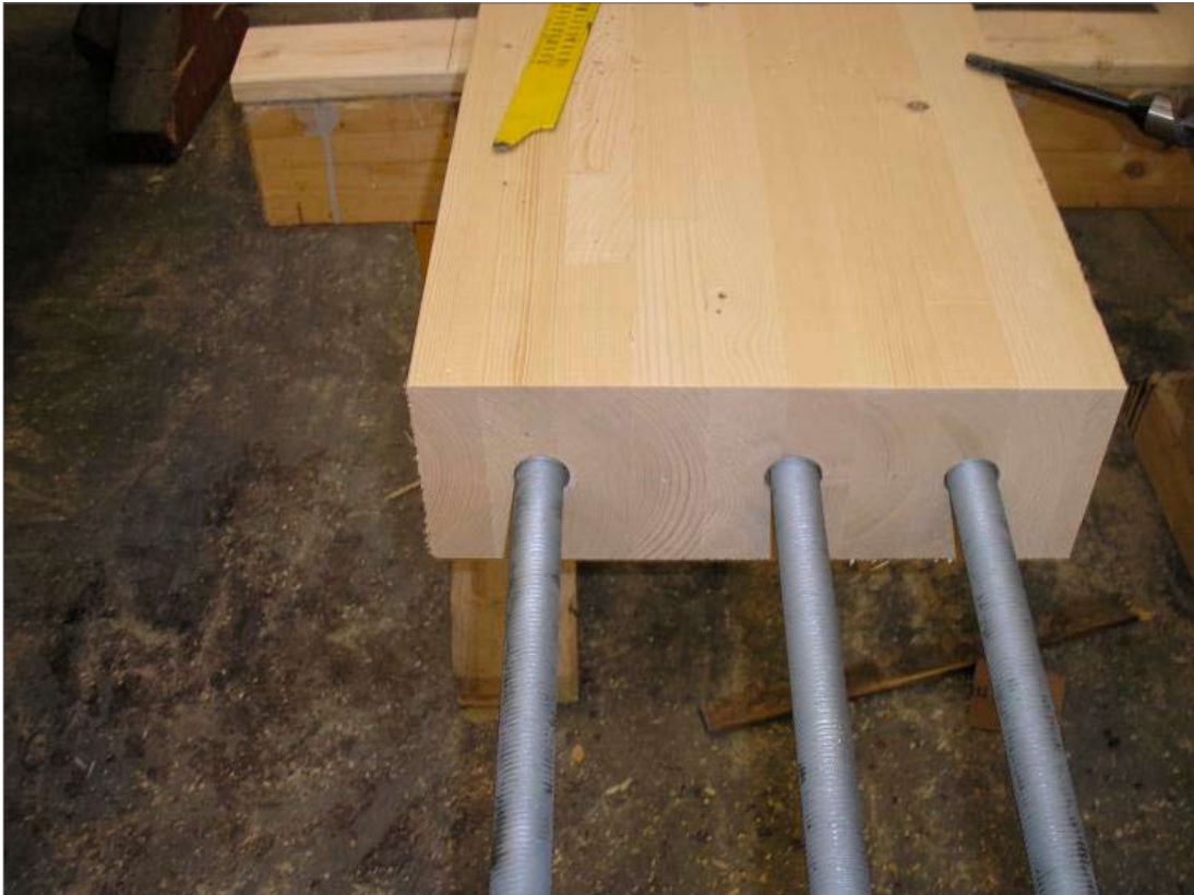
Bild 14: Einführen der Stahlstäbe in die vorbereiteten Bohrlöcher (Fa. Grossmann)
