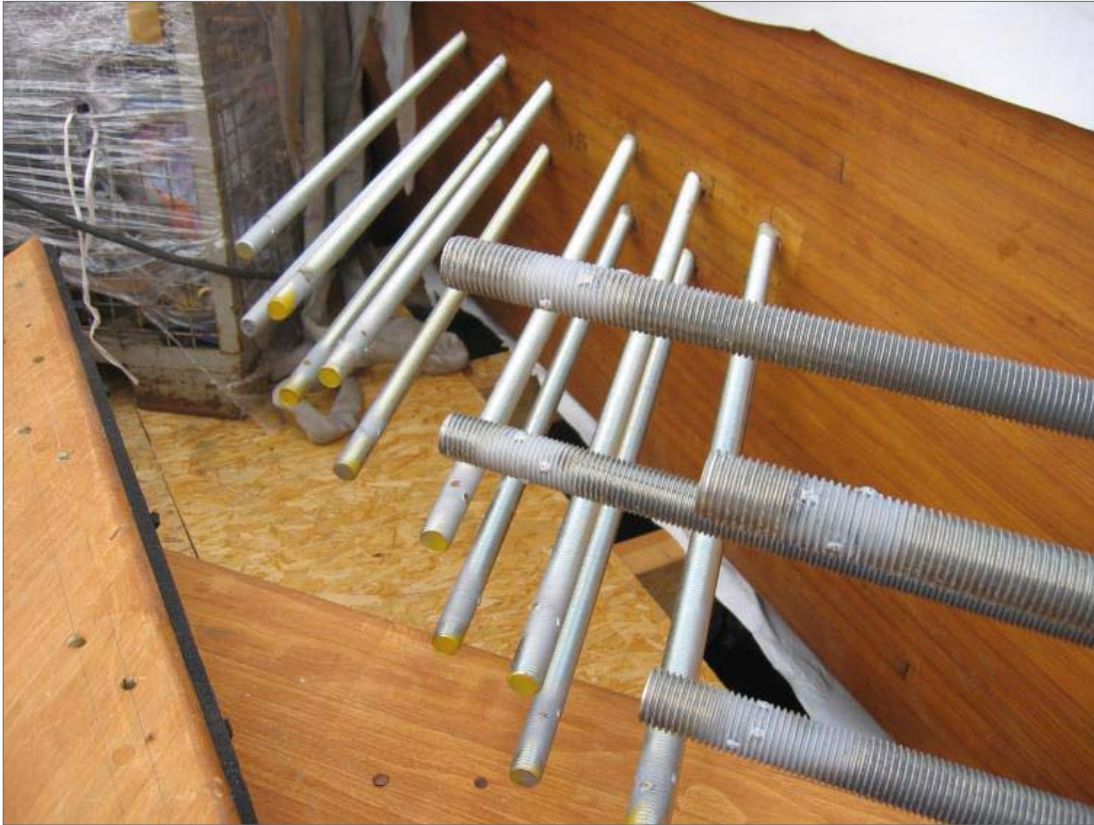
Bild 30: Einige Stahlstäbe wurden nur zum Teil mit dem Holz verklebt. Die freien Teile der Stahlstäbe dienen dem Anschluss an die anderen Konstruktionsteile (Fa. Schaffitzel)
