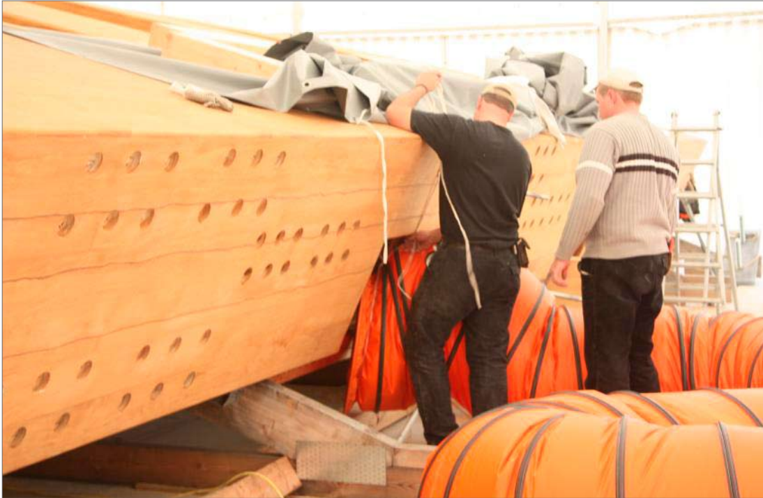
Bild 22: Bohrlöcher für die Stahlstäbe (Fa. Schaffitzel)
