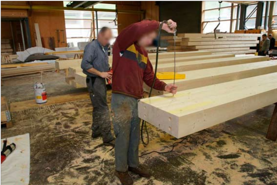
Bild 10: Säuberung der Bohrlöcher mit Druckluft (Mayr-Melnhof Kaufmann Reuthe GmbH)
