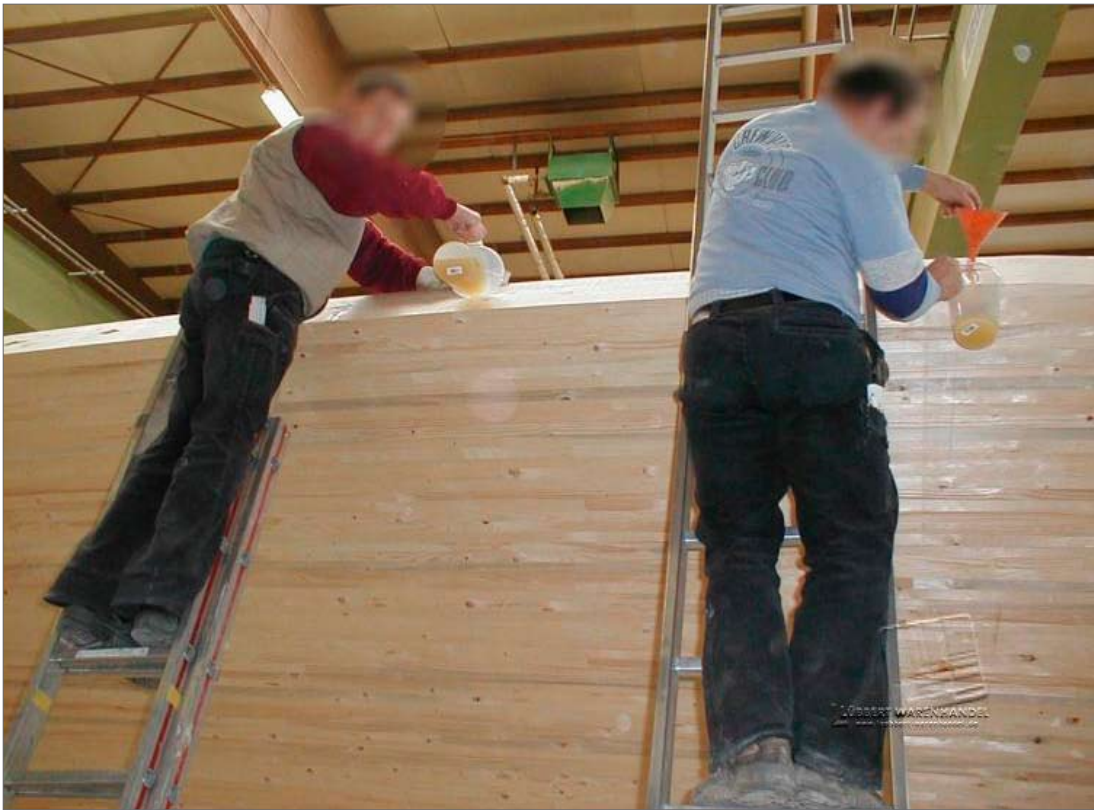
Bild 11: Einfüllen des Epoxid-Harz Klebstoffes in die Bohrlöcher (Fa. Gröber)
