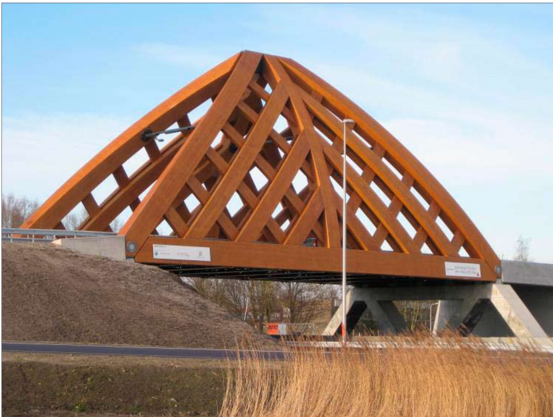
Bild 5: Mit eingeklebten Stahlstäben hergestellte Brücke Sneek (Fa. Schaffitzel)
