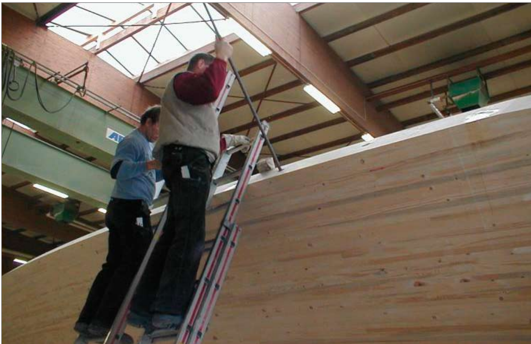
Bild 12: Einführen eines Stahlstabes in das Bohrloch (Fa.Gröber)
