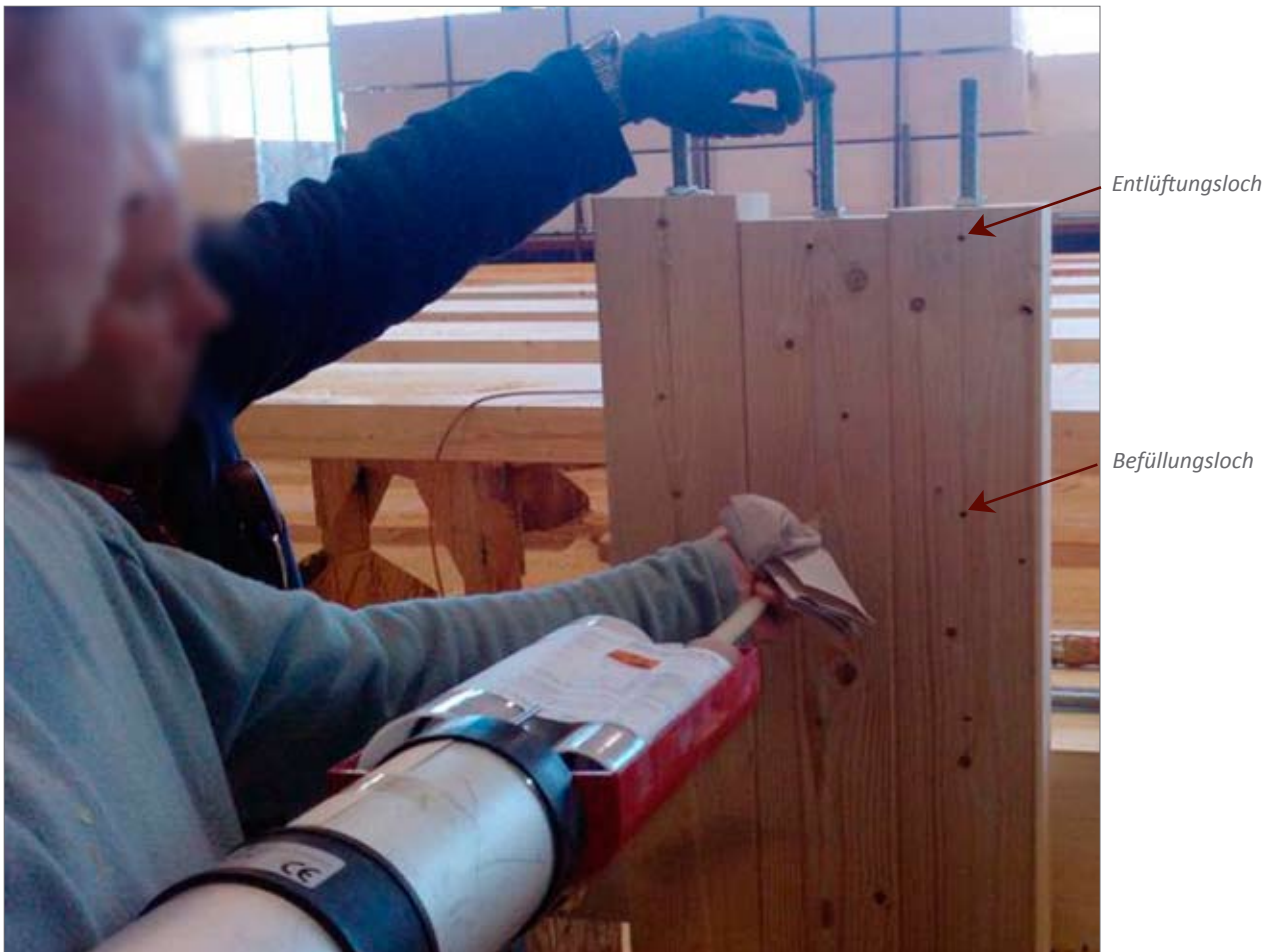
Bild 15: Einfüllen des Klebstoffes über seitliche Bohrlöcher (Fa. Derix)
