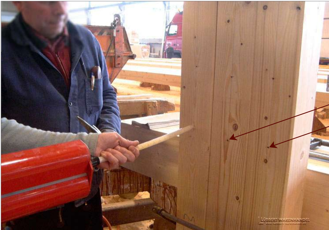
Bild 13: Seitliche Bohrlöcher zum Einfüllen des Klebstoffes (Fa. Derix)
