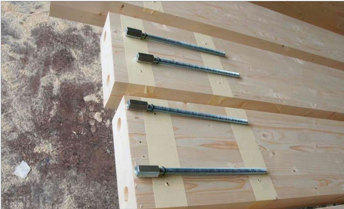
Bild 17: Seitliche Bohrlöcher zum Einfüllen des Klebstoffes, ersichtlich sind auch die vorbereiteten Bohrlöcher für die Stahlstäbe und die zu verwendenden Stahlstäbe (Mayr-Melnhof Kaufmann Reuthe GmbH)
