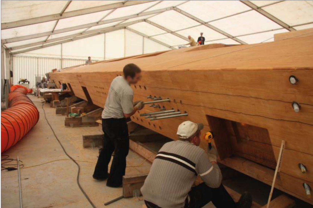
Bild 24: Zentrisches Einführen von Stahlstäben (Fa. Schaffitzel)
