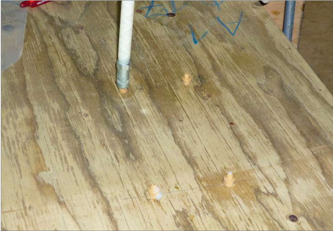
Bild 20: Einfüllen des Klebstoffs mittels Injektoren (Finnforest-Merk)
