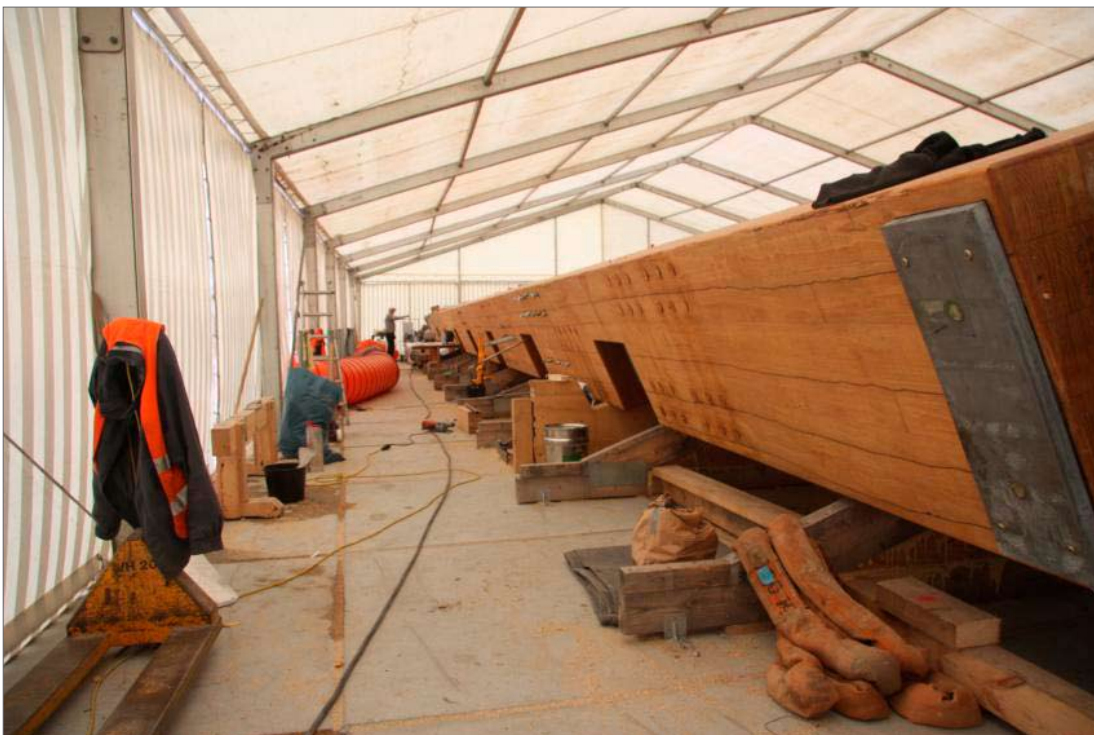
Bild 21: Blockverklebter Brettchichholzträger für die Brücke Sneek, NL, Randträger (Fa. Schaffitzel)
