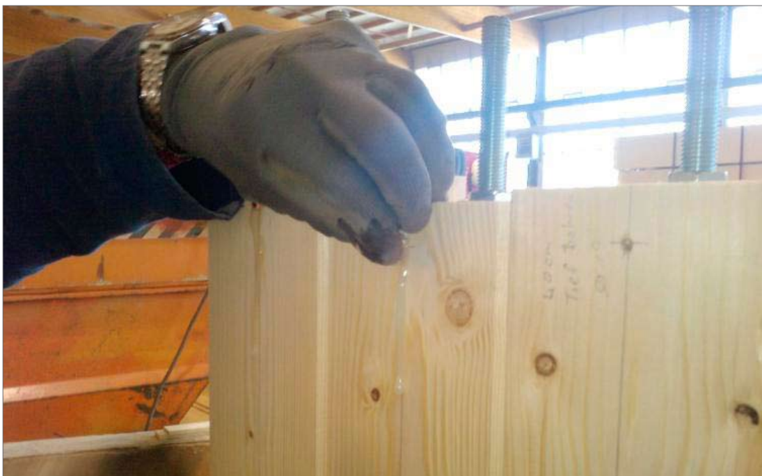
Bild 16: Austreten des Klebstoffes aus dem obersten Loch und Verschließen des Lochs mit Kunststoffdübeln (Fa. Derix)
