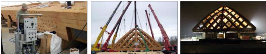
Bei diesem Projekt wurde das WEVO-Spezialharz EP 20 VP 1 mit dem WEVO-Härter B 20/1 eingesetzt
