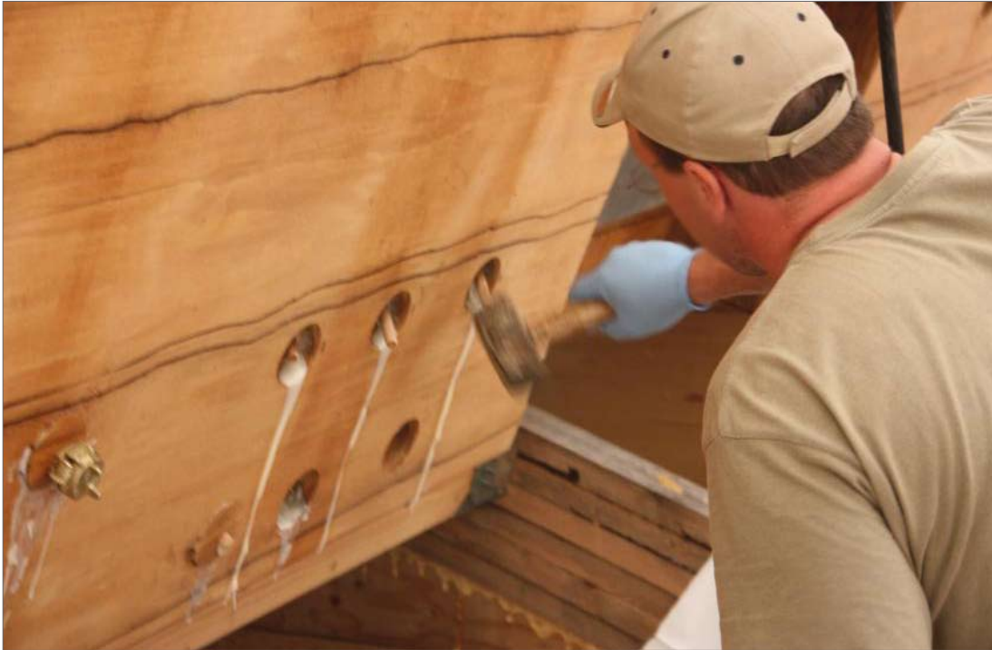
Bild 28: Verschließen der Löcher für den Hohlbohrer mit Holzdübeln (Fa. Schaffitzel)
