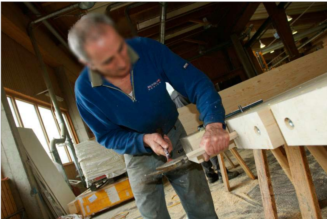
Bild 18: Positionierung des Stahlstabes in dem vorbereiteten Bohrloch (Mayr-Melnhof Kaufmann Reuthe GmbH)
