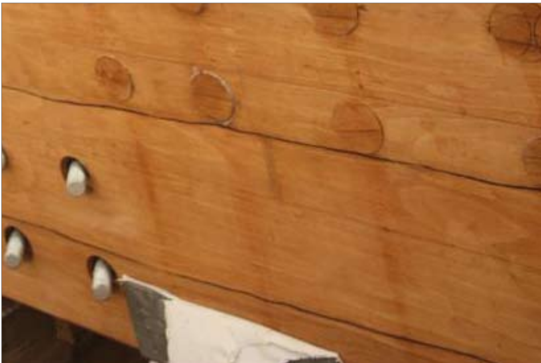
Bild 25: fast vollständig eingeführte Stahlstäbe (Fa. Schaffitzel)
